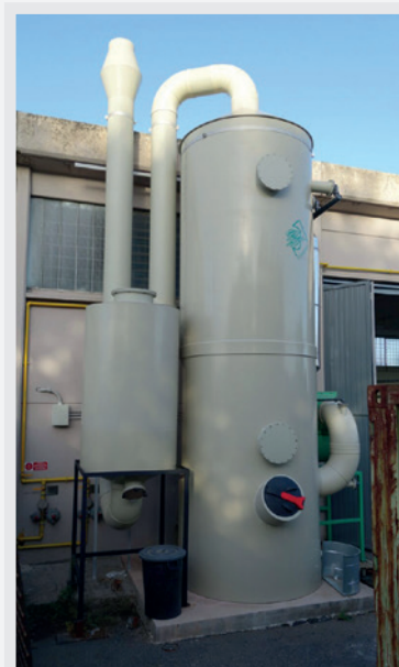
Fumes Scrubber Torre di lavaggio fumi (ITALIA)
