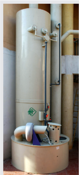
Alkaline Fumes Scrubber Torre di lavaggio fumi alcalina Hyderabad (INDIA)
