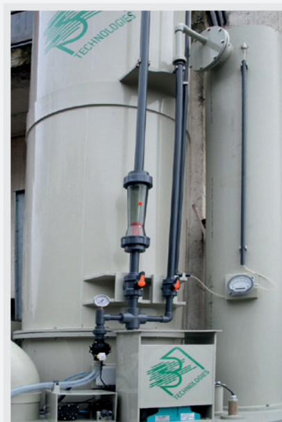
Fumes Scrubbers Torri di abbattimento fumi (USA)
